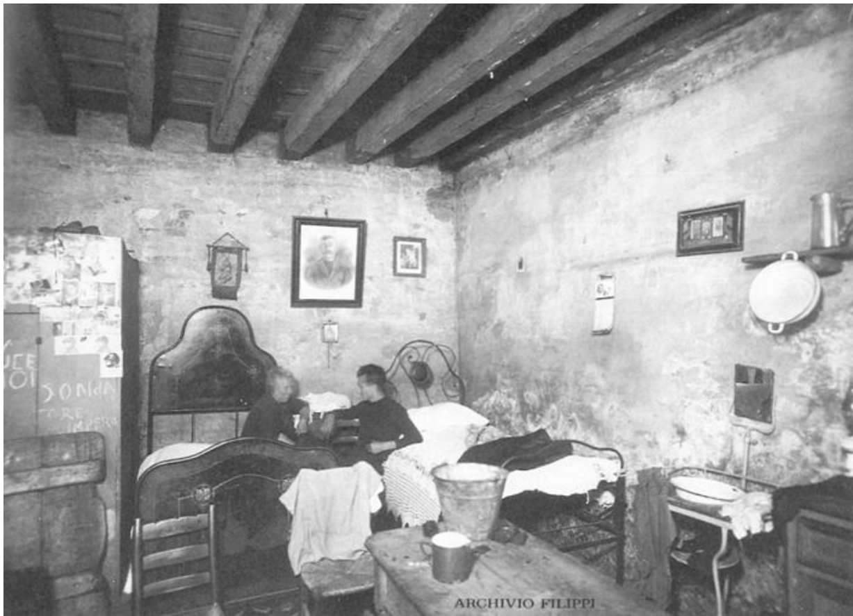
Fig. . Precarie condizioni abitative Calle delle Colonne, settembre 1937
